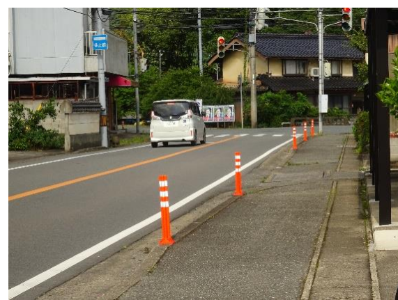
坂本方面から三叉路へ(ラバーポールの設置)
