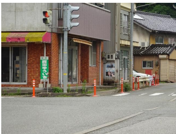
伊佐交差点信号付近(ラバーポールの設置)
