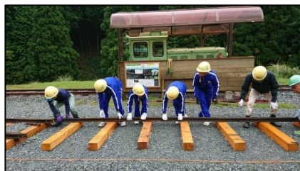
〈枕木を並べ、レールの敷設〉
