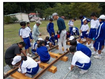
レールの敷設作業の様子
