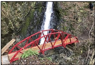
<天滝への遊歩道にあるトラフ橋>
