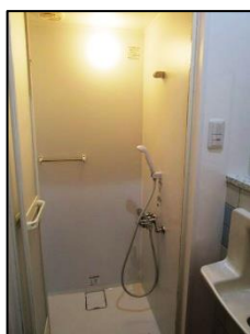
<完成したシャワー室>
