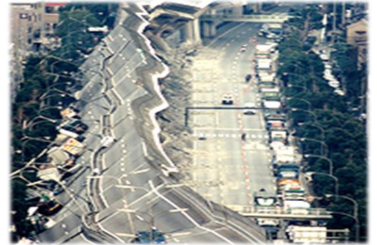
阪神淡路大震災で倒壊した高速道路
